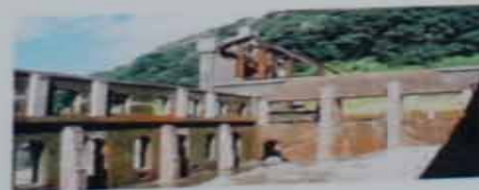
5. 完成写真(1) 100年前の古いレンガ壁を長寿レンガが リットレス工法(たてに積まれたレンガ) で支えています。
