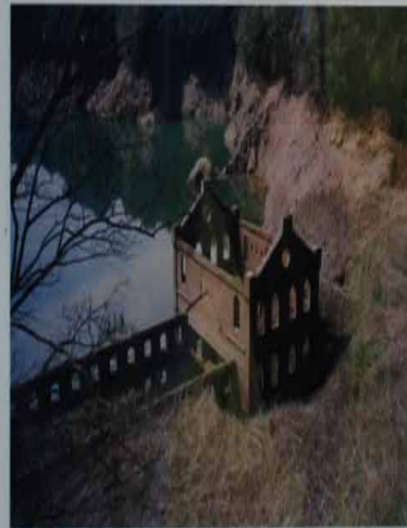
ドイツの設計だと思われる 発電所の建物 平成7年当時の状況写真
