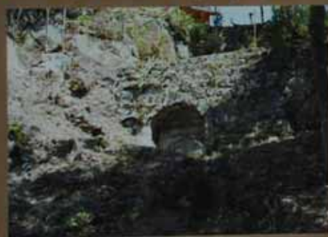
石積みヘッドタンクを正面から見る (ここから水を発電所へ送っていた)
