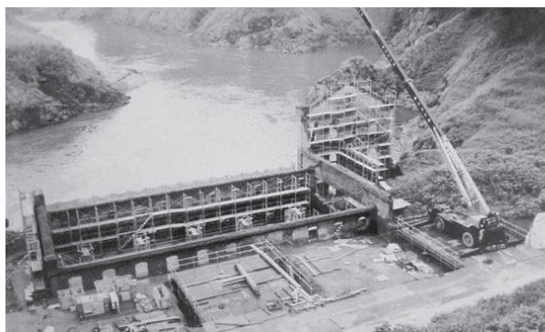
写真3 2005年に始まった保存工事
